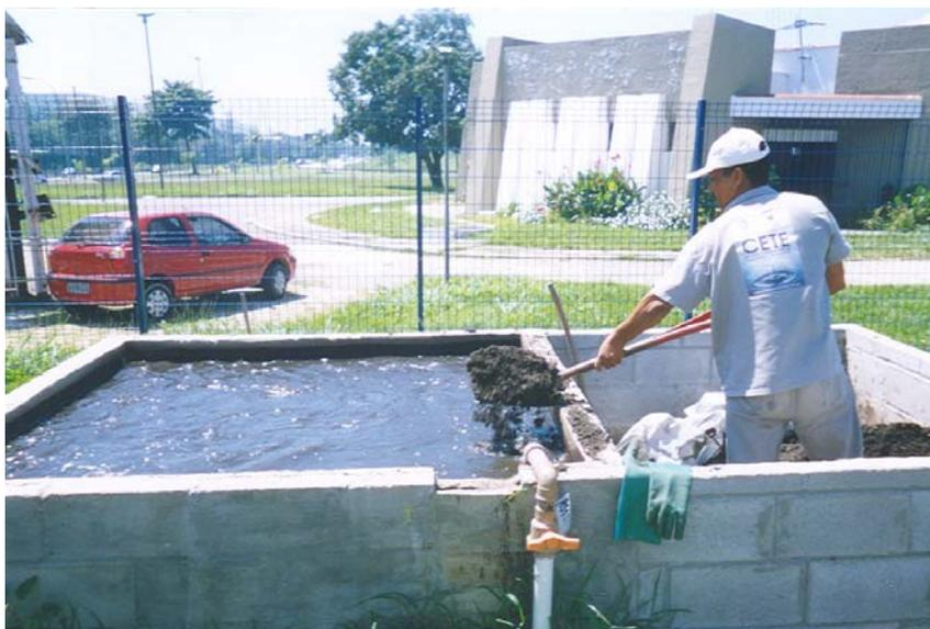
**Figura 3. 5** - Tanque de equalização de lodo
