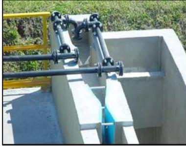
**Figura 33: Chegada da Tubulação a Calha de Concreto**
