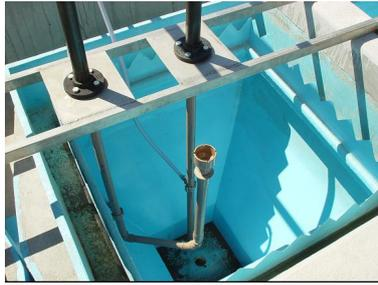
**Figura 29: Detalhe do fundo do decantador**
