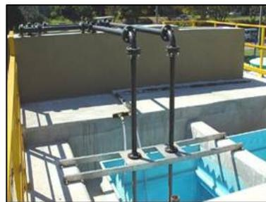
**Figura 32: Saída da tubulação de recirculação**
