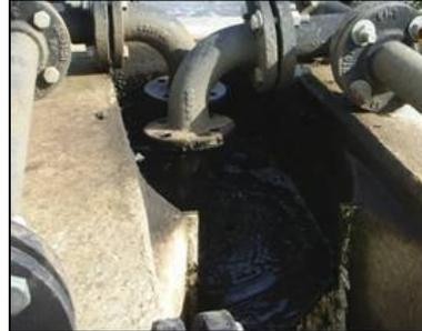
**Figura 34: Entrada do Lodo a Calha de Concreto**
