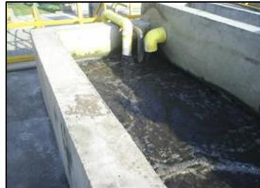
**Figura 27: Entrada do Esgoto Bruto e da Recirculação de Lodo**
