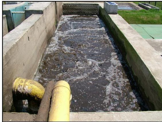
**Figura 8: Presença de biomassas em suspensão e aderida em um Reator MBBR**
