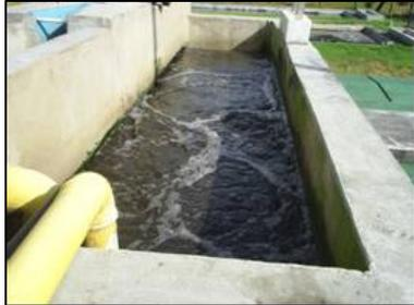
**Figura 26: Tanque de Aeração**
