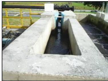
**Figura 35: Passagem do Lodo pela Calha Parshall**
