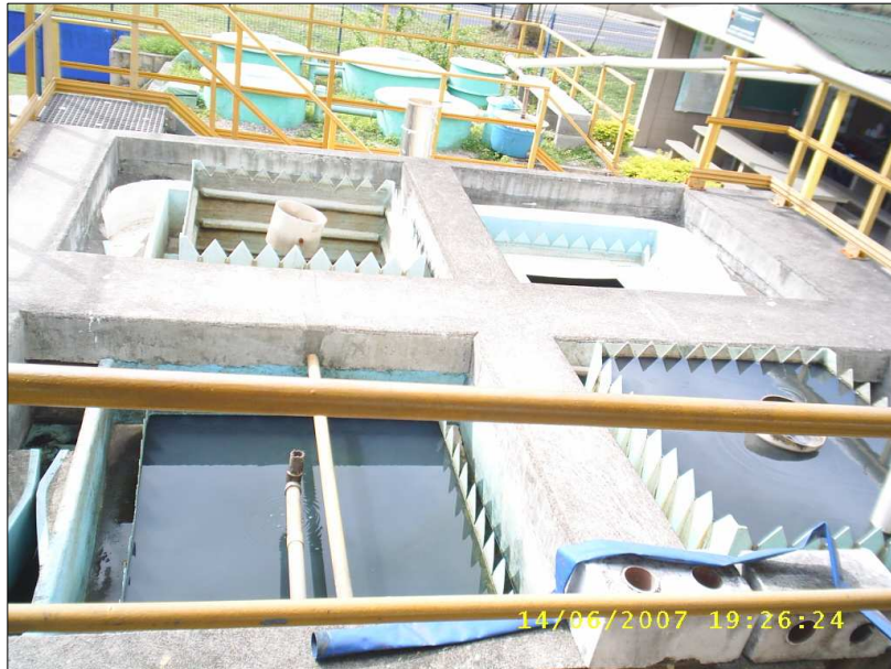
Figura A.6 – Decantação primária convencional
