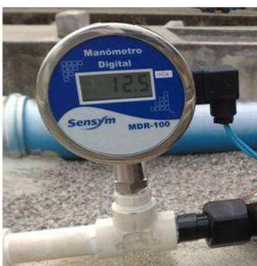
Figura 50: Manômetro Digital localizado a montante e a jusante das unidades monitoradas.
