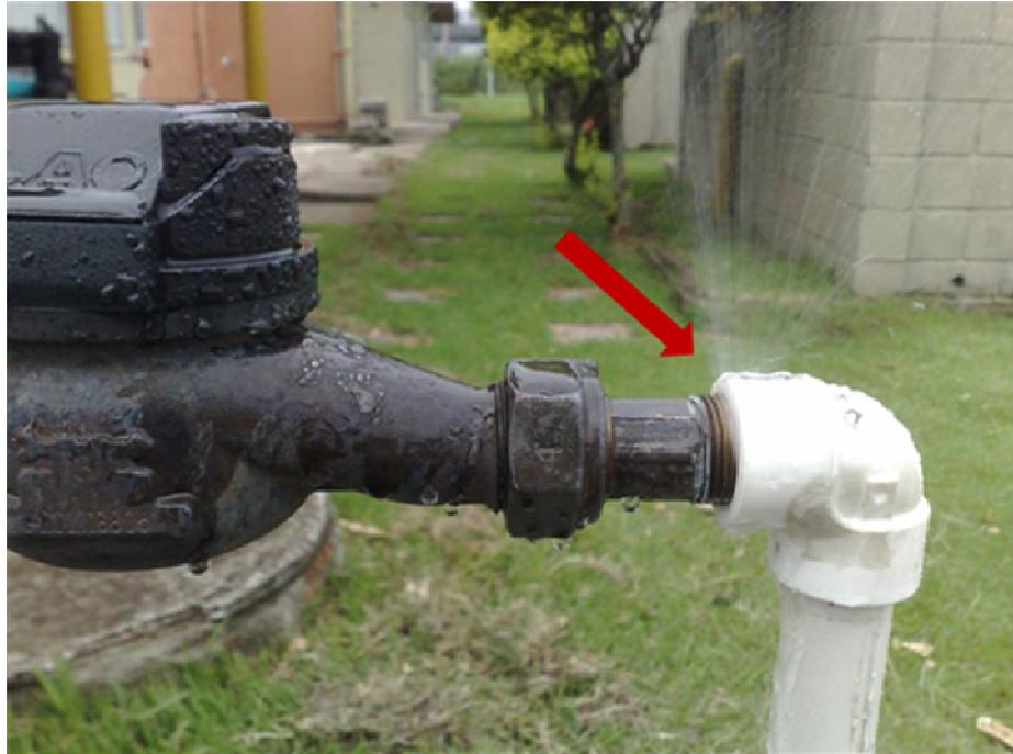
Figura 53: Perda de água relacionada à incorreção de montagem no hidrômetro de um cavalete de micromedição.
