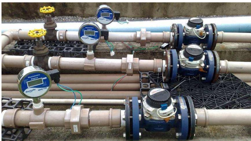
Figura 57: Detalhamento dos sistemas de controle de pressão e vazão para o monitoramento da rede de abastecimento.
