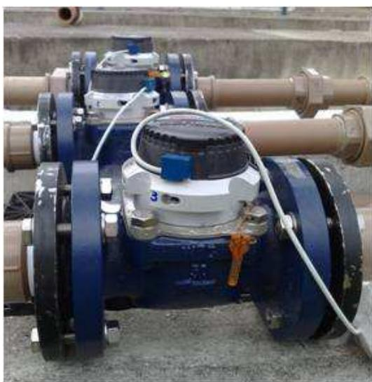
Figura 58: Medidor de vazão tipo woltman instalado a montante e a jusante do sistema.
