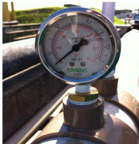
Figura 61: Manômetro analógico instalado ao lado do furo na tubulação.
