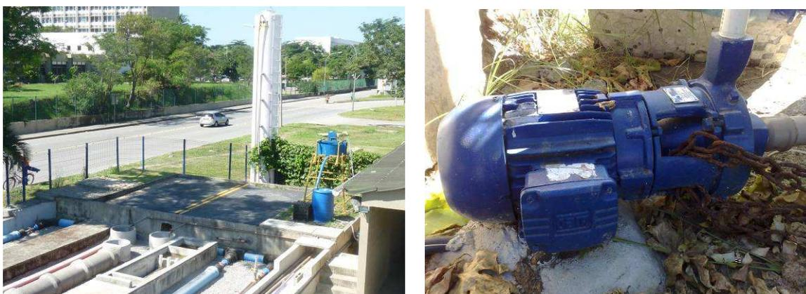
Figura 47: Reservatório elevado tipo castelo d'água e *Booster* pressurizador *in line*.
