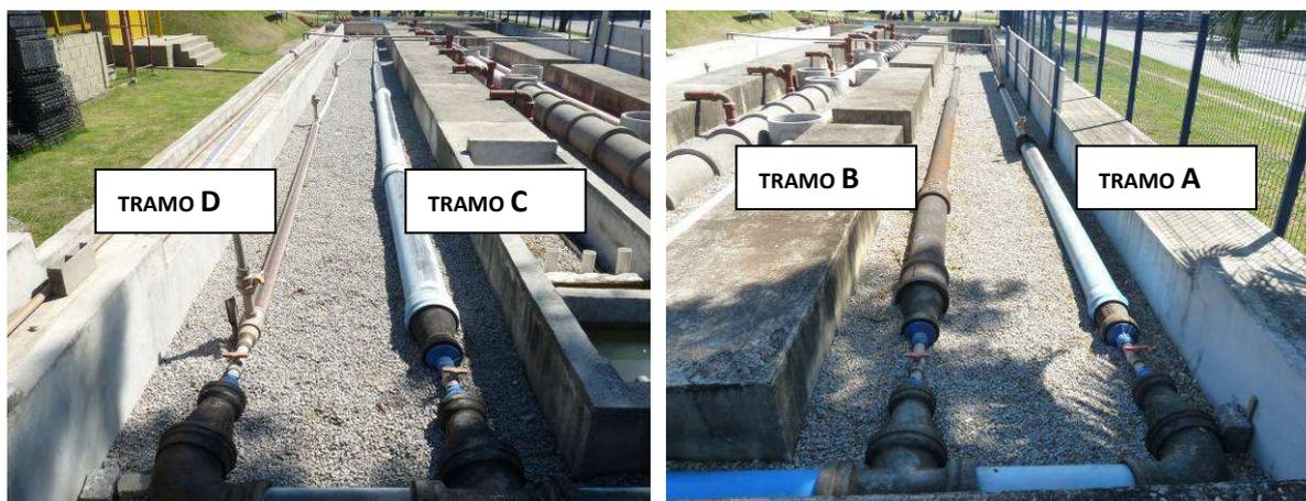
Figura 46: Derivação dos quatro tramos da rede de distribuição, nomeados com as letras A, B, C e D.
